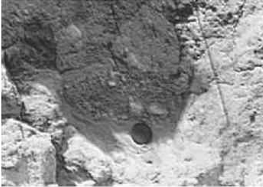
Figura 3 - Estrutura de túnel preenchido localizado em parede de voçoroca na encosta Monjolo (Lapa-PR)
